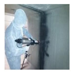
**PolyeXpress** E' una speciale formulazione di Polyurea specificamente progettata per le riparazioni e le operazioni di manutenzione su piccole superfici ( < 20m² ) assicurando portabilità, semplicità e durata nel tempo.
