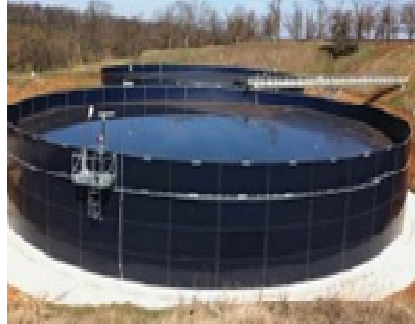
Trattamento acque reflue
