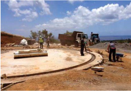
Preparazione base di appoggio
