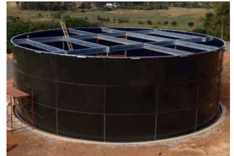
Preparazione base per tetto
