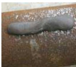
Posizionare il Putty sulla zona oggetto dell'intervento e comprimere con forza in modo che il prodotto penetri nella rottura (foro, giunzione, etc.). In alternativa al Putty si può utilizzare la pezza in dotazione.
