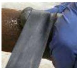
Esercitare la massima pressione sul nastro in modo da comprimere l'area interessata e continuare ad avvolgere a spirale per sovrapposizione fino al completo utilizzo del nastro in dotazione. Una volta ultimato l'intervento, verificare se vi sono ancora perdite ed in tal caso ricominciare il lavoro con un nuovo Putty
