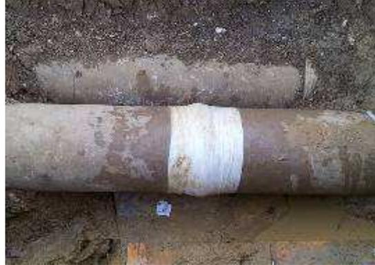
*riparazione di un tubo in cemento amianto*
