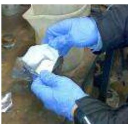
Una volta assicurati che la fase idraulica sia terminata favorevolmente, si passa alla fase meccanica. Pulire accuratamente la superficie oggetto dell'intervento. Proteggere le mani con i guanti in dotazione nel kit, aprire il sacchetto sigillato contenente la benda Synto Glass e versarvi dell'acqua o immergete la fascia in un secchio. Attendere 30 secondi circa
