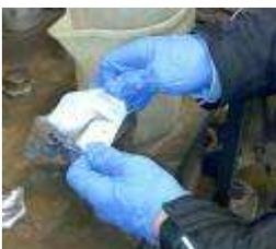
Una volta assicurati che la fase idraulica sia terminata favorevolmente, si passa alla fase meccanica. Pulire accuratamente la superficie oggetto dell'intervento. Proteggere le mani con i guanti in dotazione nel kit, aprire il sacchetto sigillato contenente la benda Synto Glass e versarvi dell'acqua o immergere la fascia in un secchio. Attendere 30 secondi circa
