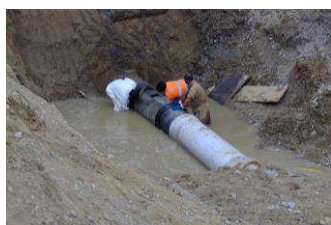
intervento di riparazione condotta fognaria
