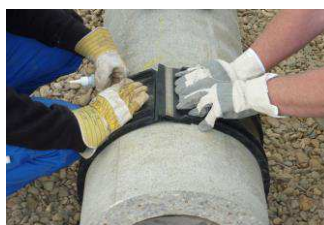
pulire il tubo e posizionare il giunto
