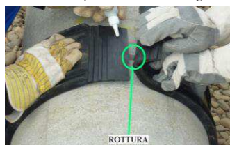
applicare la fascia sulla rottura e incollare
