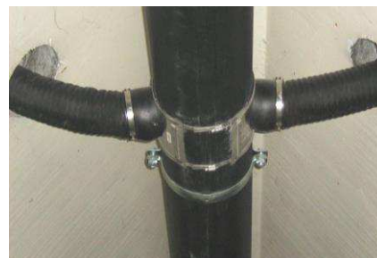
applicazione doppio T-flex su tubi PE
