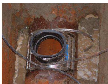
applicazione doppio T-flex su tubi PE
