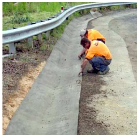
modellamento del CC sul terreno
