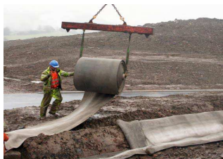
1: Adagiare il CC sulla superficie da trattare
