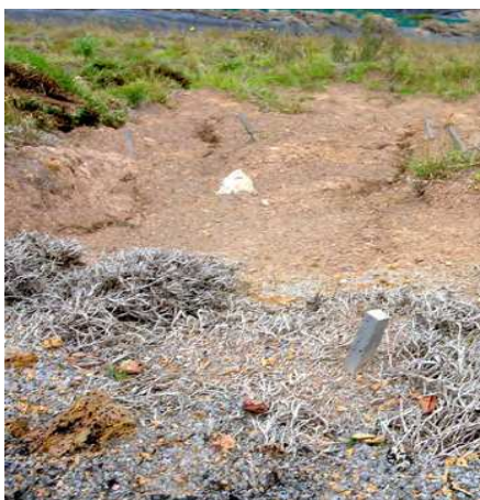
zona interessata dalla frana vista monte
