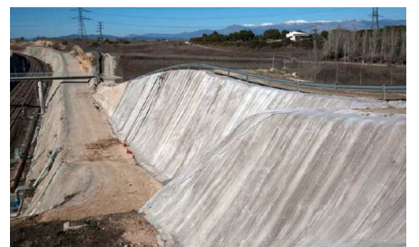
stabilizzazione di scarpata in prossimità della linea ferroviaria ad alta velocità
