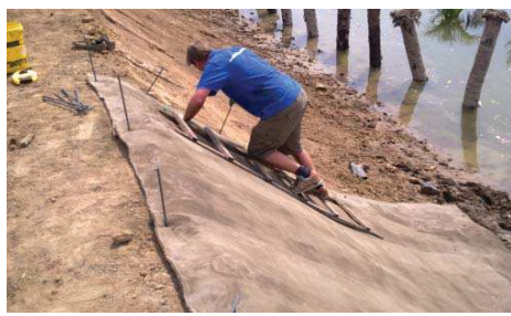
fase di ancoraggio
