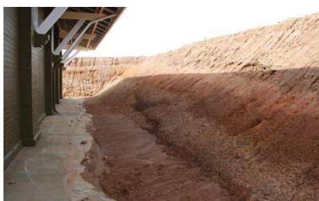
problema: frane nel perimetro dell'edificio
