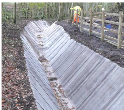
CC si srotola e si stende con rapidità per realizzare canali e canalette con geometrie variabili a piacere. Facile, veloce e meno costoso rispetto ai sistemi tradizionali. La produzione oraria è di circa 200mq con una squadra di tre persone
