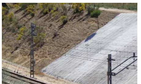
stabilizzazione di scarpata in prossimità della linea ferroviaria ad alta velocità
