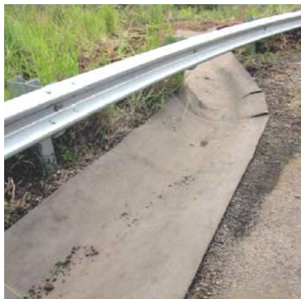
particolare canaletta in curva a monte
