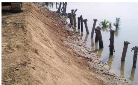
ripulire e risagomare l'area d'intervento
