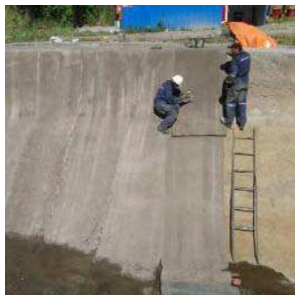
applicazione di CC sulle pareti
