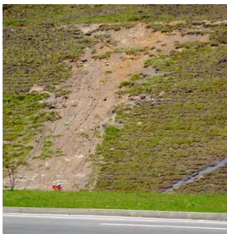
zona interessata dalla frana vista valle
