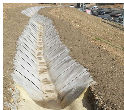
CC si srotola e si stende con rapidità per realizzare canali e canalette con geometrie variabili a piacere. Facile, veloce e meno costoso rispetto ai sistemi tradizionali. La produzione oraria è di circa 200mq con una squadra di tre persone
