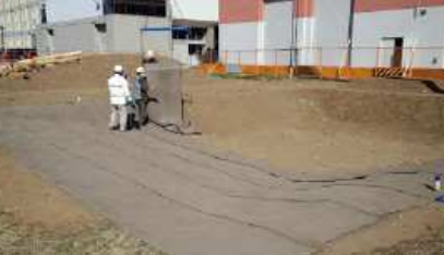
si procede allo srotolamento del CC
