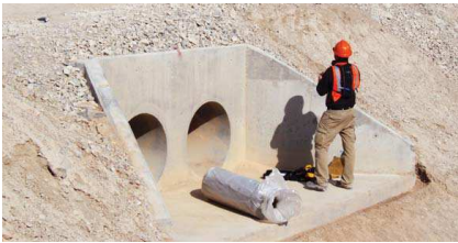
messa in sicurezza di una zona soggetta a dilavamento nel periodo delle piogge
