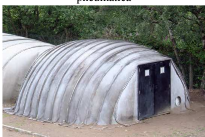
dopo due ore dall'idratazione la struttura è pronta per essere utilizzata
