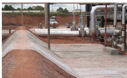
lavoro ultimato - vista laterale
