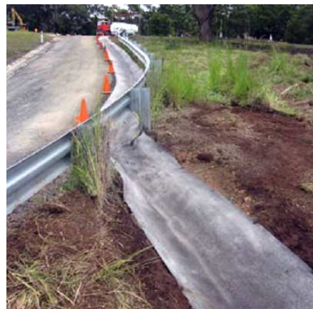
particolare canaletta a valle
