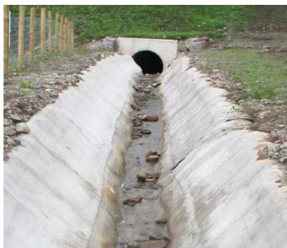
CC si srotola e si stende con rapidità per realizzare canali e canalette con geometrie variabili a piacere. Facile, veloce e meno costoso rispetto ai sistemi tradizionali. La produzione oraria è di circa 200mq con una squadra di tre persone
