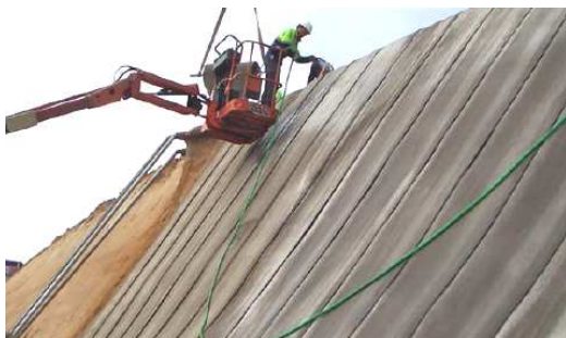
utilizzato per stabilizzare e proteggere le scarpate come un sostitutivo delle reti metalliche e del cls spruzzato
