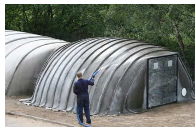
ancorare la struttura al suolo e idratare abbondantemente con acqua
