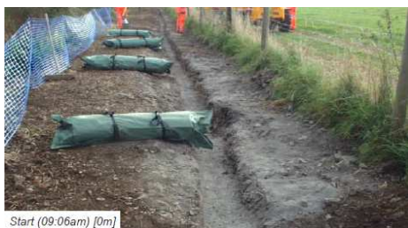
pulizia e profilatura della canaletta
