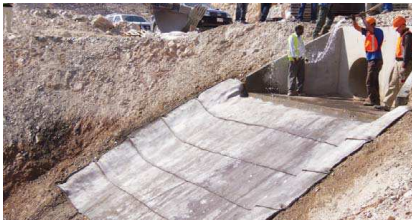
stendere il tessuto CC, ancorarlo e idratarlo abbondantemente
