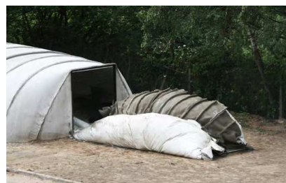
applicare una ventola elettrica per gonfiare la struttura sino al suo auto-sostegno
