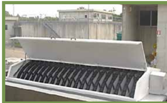
IMPIANTO DI FILTRAZIONE A TELA
