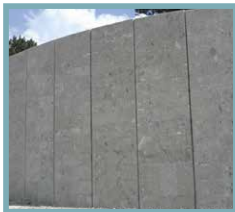
MURI DI SOSTEGNO
