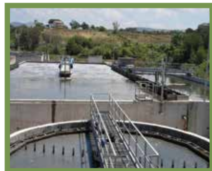
PONTE ISPESSITORE A COMANDO CENTRALE
