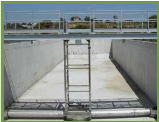
PONTE LONGITUDINALE ASPIRATO
