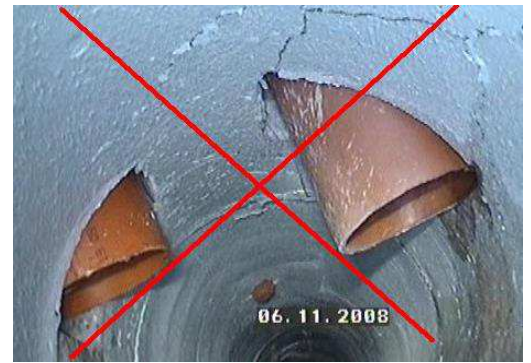
problemi dovuti ad innesti laterali senza T-flex
