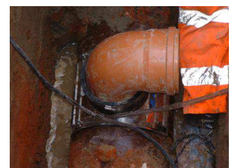
T-flex su tubi di PVC , fibrocemento e vetroresina
