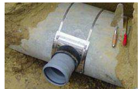
T-flex su tubi di PVC , fibrocemento e vetroresina
