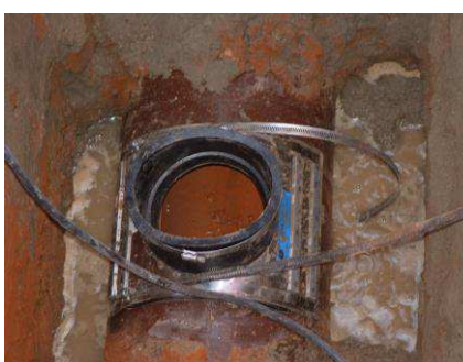
applicazione doppio T-flex su tubi PE
