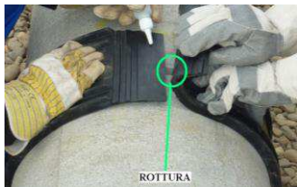
applicare la fascia sulla rottura e incollare
