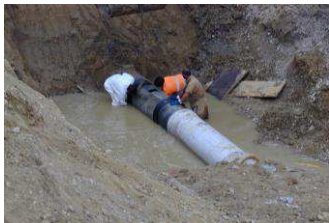
intervento di riparazione condotta fognaria
