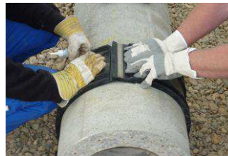
pulire il tubo e posizionare il giunto
