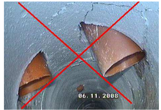
problemi dovuti ad innesti laterali senza T-flex
