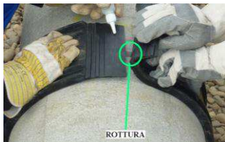
applicare la fascia sulla rottura e incollare
