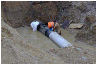
intervento di riparazione condotta fognaria
