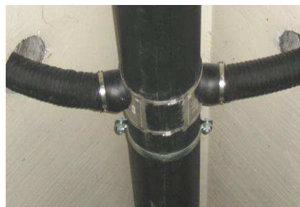
applicazione doppio T-flex su tubi PE
