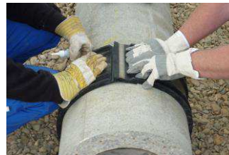
pulire il tubo e posizionare il giunto
