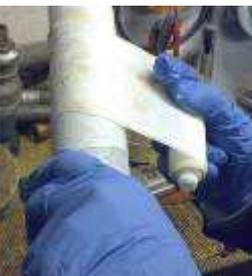
Utilizzate tutta la fascia a disposizione nel kit, strizzate e modellate la fasciatura ad ogni giro in modo da rimuovere eventuali eccessi di acqua. Per rendere la superficie esterna più liscia, appena terminata l'operazione di avvolgimento di Synto Glass, prendere il film in polietilene in dotazione ed avvolgerlo intorno alla fasciatura. Trascorso il tempo di maturazione, la condotta può tornare in esercizio (max 12 bar).
