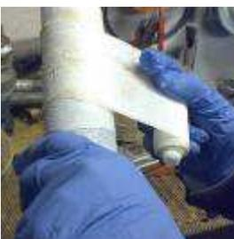
Utilizzate tutta la fascia a disposizione nel kit , strizzate e modellate la fasciatura ad ogni giro in modo da rimuovere eventuali eccessi di acqua. Per rendere la superficie esterna più liscia, appena terminata l'operazione di avvolgimento di Synto Glass , prendere il film in polietilene in dotazione ed avvolgerlo intorno alla fasciatura. Trascorso il tempo di maturazione, la condotta può tornare in esercizio (max 12 bar) .
