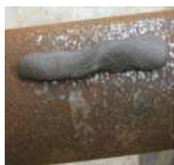
Posizionare il Putty sulla zona oggetto dell'intervento o in prossimità della stessa (in caso di perdita attiva). Prendere il nastro di contenimento in dotazione ed avvolgerlo prima sull'area adiacente all'intervento per ancorarlo e successivamente avvolgerlo sulla zona dove precedentemente è stato posizionato il Putty
