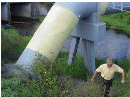
**PROBLEMA** : Una condotta forzata di acque reflue in cemento armato precompresso del DN 1200mm ha una corrosione estesa dovuta all'idrogeno solforato che ne ha compromesso la tenuta e ha determinato un rischio di cedimento strutturale del tubo essendosi ridotto lo spessore del 30% . Il punto è localizzato fuori terra sull'attraversamento aereo di un fiume.
