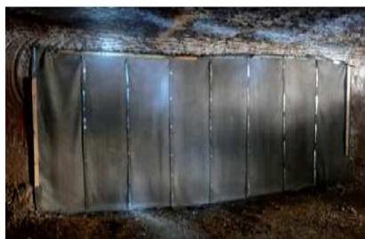
sostitutivo del cls spruzzato nei muri, protezione all'abrasione, opere di difesa dalle esondazioni, rivestimento di miniere
