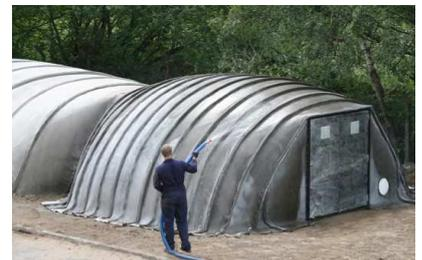
ancorare la struttura al suolo e idratare abbondantemente con acqua
