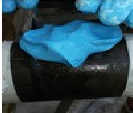
**EUROSUB (BLU )** è un Formulato bicomponente a base di resine epossidiche esente da solventi che può essere utilizzato su supporti bagnati o sott'acqua. L'indurimento avviene per reazione a freddo. Il materiale è impermeabile al vapore, all'acqua, ai combustibili e lubrificanti ed inoltre presenta una elevata resistenza chimica alle soluzioni basiche, debolmente acide, organiche. Caratteristiche meccaniche dopo 7 gg a 23°C
