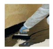
**PolyeXpress** E' una speciale formulazione di Polyurea specificamente progettata per le riparazioni e le operazioni di manutenzione su piccole superfici ( < 20m² ) assicurando portabilità, semplicità e durata nel tempo.
