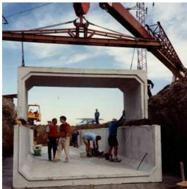
A richiesta possono essere realizzati manufatti scatolari di grandi dimensioni realizzati con due elementi ad U da accoppiare in cantiere con sistema ad incastro e spinotti di collegamento. Il nostro ufficio tecnico è a vostra disposizione.
