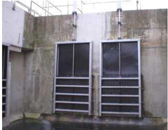
VOCE DI CAPITOLATO : Fornitura di paratoia murale a ghigliottina con tenuta nei due sensi di flusso per utilizzo in acque di superficie , scarichi e ambienti aggressivi ; carico idraulico 5 m ; applicazione su parete verticale ; ghigliottina e pannello posteriore in PEAD ; telaio e nervatura in acciaio inox AISI 316L ; guarnizione di tenuta in EPDM ; azionamento con vite non saliente in acciaio inox AISI 316L con filetto trapezoidale , passo 6mm , chiusura in senso orario .
