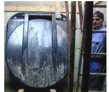
**VOCE DI CAPITOLATO :** Fornitura di valvola antiriflusso fine linea costruita in poliestere rinforzato e gel-cot isofoalico , metallerie in acciaio inox AISI 316 , flangiata per accoppiamento a parete verticale ; battente inclinato ; tenuta idraulica 1 bar ; guarnizione di tenuta in EPDM
