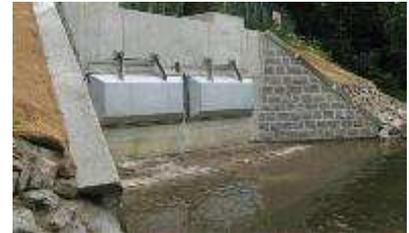
VOCE DI CAPITOLATO : fornitura di valvola a clapet in acciaio ..... ( zincato – inox AISI 304 ) a sezione rettangolare o quadrata; esecuzione compatta con tenuta su quattro lati; tenute in EPDM, carico idraulico max 5 m ; a richiesta sistema a contrappesi per regolazione in campo; telaio con struttura autoportante per fissaggio a muro con tasselli chimici o zanche per inghisaggio a muro (a richiesta)
