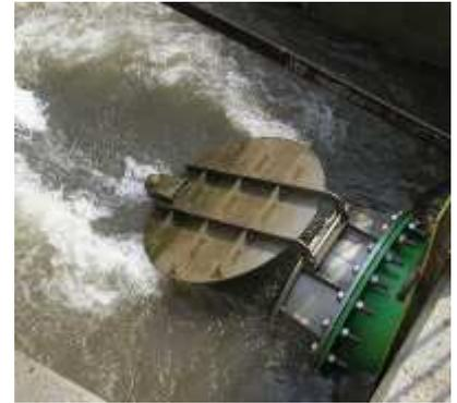
**VOCE DI CAPITOLATO** : fornitura di valvola a clapet in acciaio inox AISI ..... ( 304 – 316 Ti ) a sezione circolare in esecuzione compatta con tenuta su tutta la circonferenza ; tenute in EPDM , carico idraulico max 6 m ; telaio con struttura autoportante ; per fissaggio a .....( muro – flangia PN 10 )
