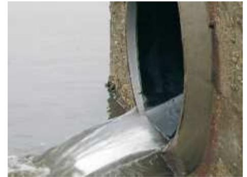
**VOCE DI CAPITOLATO :** Fornitura di valvola antiriflusso WS in gomma del tipo azionato dal fluido da inserire all'interno di una condotta ; corpo flessibile deve essere costruito in un unico pezzo di gomma contenuto all'interno di un guscio in acciaio inox AISI 304. Tenuta idraulica 5m H2O
