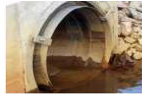
**VOCE DI CAPITOLATO :** Fornitura di valvola antiriflusso WS in gomma del tipo azionato dal fluido da applicare in linea su condotta De ..... mm ; corpo flessibile deve essere costruito in un unico pezzo di gomma contenuto all'interno di un guscio in acciaio inox AISI 304 - PVC - PEAD. Tenuta idraulica 5m H2O
