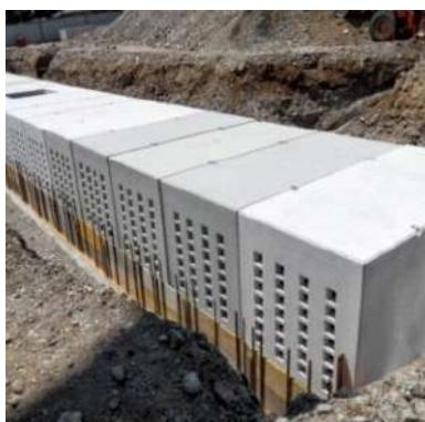
Scatolari e sistemi di drenaggio in cemento
