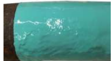
Resina bi-componente con rinforzo in fibre di KEVLAR
