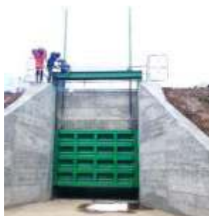
Paratoia in acciaio inox e zincato a sezione rettangolare
