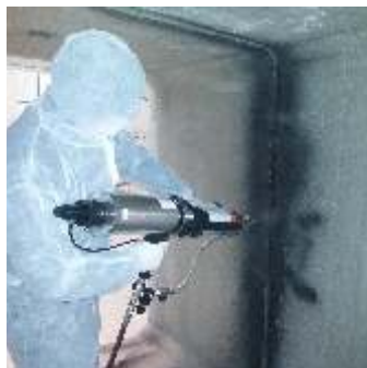
Rivestimento e protezione vasche e canali
