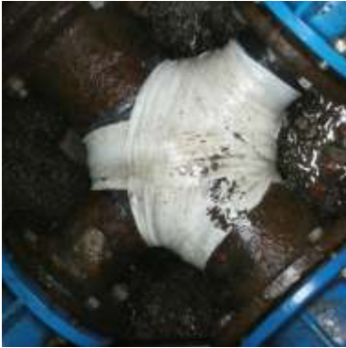
Kit per la riparazione condotte con pressione in esercizio SG-PR
