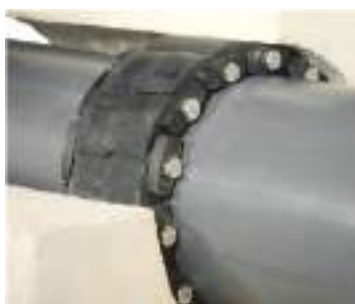
Giunto passamuro Wall bushing
