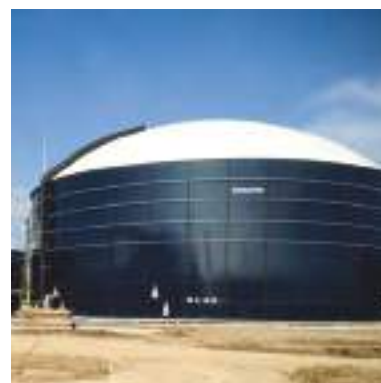
Strutture modulari per la realizzazione di serbatoi e silos Modular bolted tank
