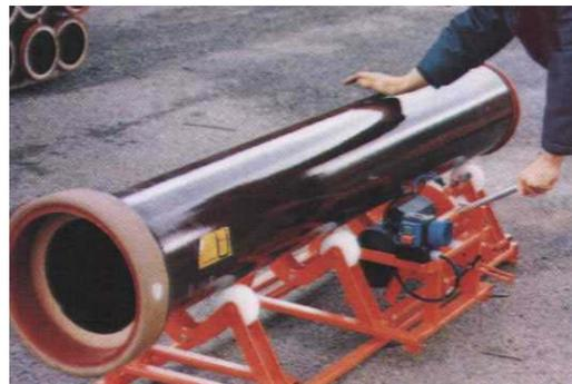
I bordi di taglio devono essere smussati con una rifilatrice o mediante una grossa cote.
