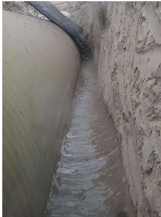
Figura 4.9 Installazione di un tubo interrato in PRFV con il metodo CLSM
