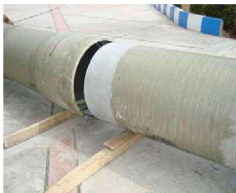
Figura 5.22 Allineamento dei tubi
