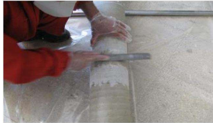
Figura 5.29 Rimozione dei grumi mediante limatura
