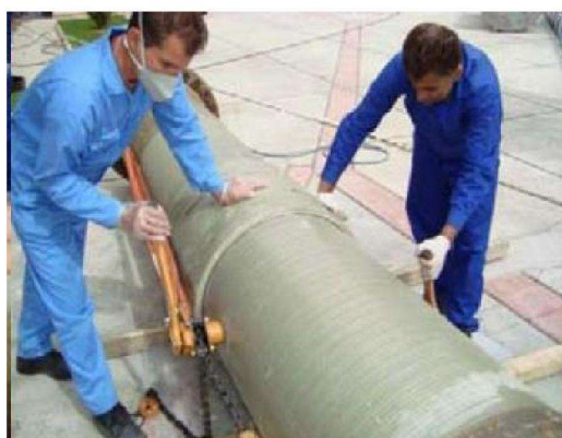
Figura 5.23 Insetimento di un tubo nel raccordo
