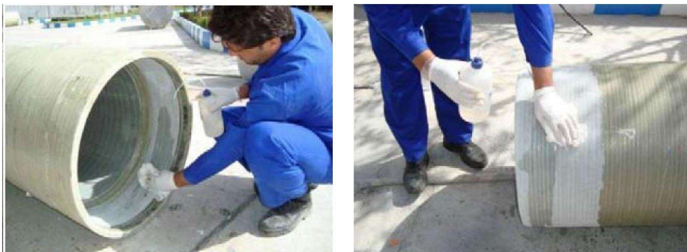
Figura 5.19 Pulizia delle scanalature della guarnizione e della superficie rettificata del tubo
