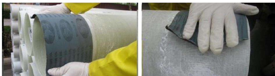
Figura 5.15 Utilizzo della carta vetrata per l'esterno del raccordo
