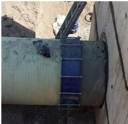
Figura 511 Accoppiamento meccanico Viking-Johnson
