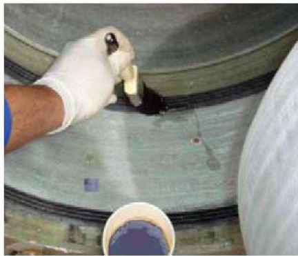
Figura 5.21 Lubrificazione della guarnizione e delle superfici rettificate con colla e pennello
