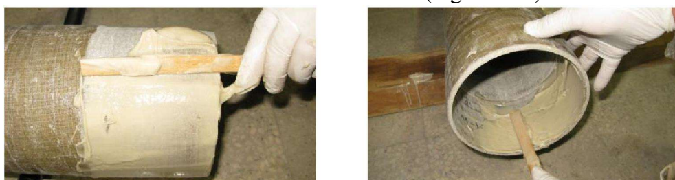
Figura 5.16 Applicare la colla sulle superfici del raccordo e della campana
