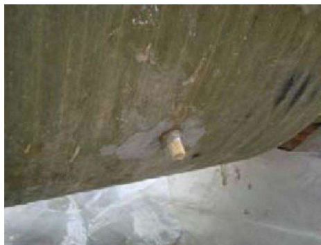
Figura 5.25 Tappo nel foro dopo l'iniezione di colla
