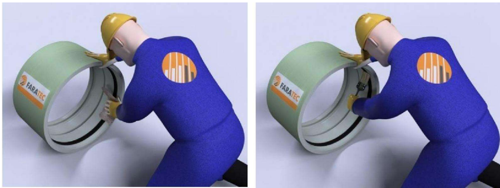
Figura 55 Lubrificazione della guarnizione
