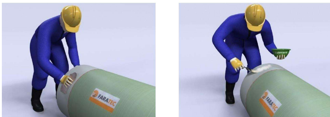
Figura 54 lubrificazione dei raccordi
