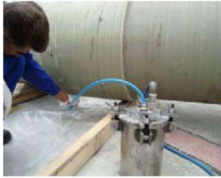
Figura 5.24 Iniezione di colla attraverso il foro di incollaggio con l'ausilio di un compressore ad aria compressa
