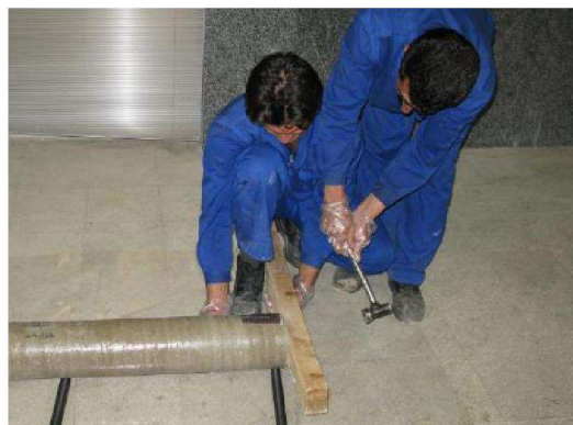
Figura 5.17 Infissione di un beccuccio in una campana con un legname e un martello
