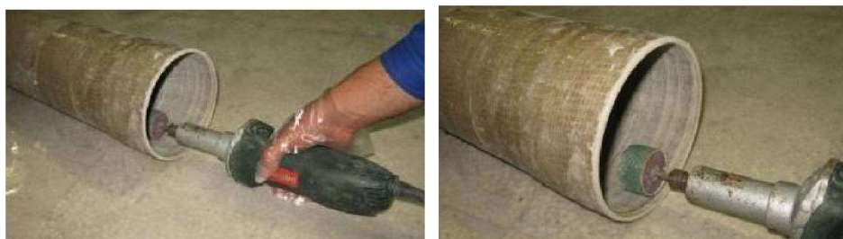
Figura 5.14 Smerigliatura dell'interno della campana con una smerigliatrice per
