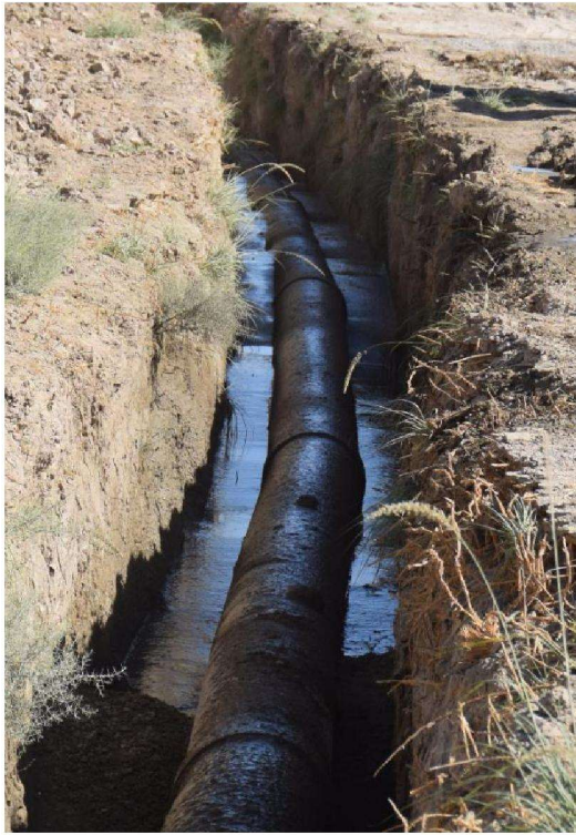
Figura 4.9 Installazione di un tubo interrato in PRFV con il metodo CLSM
